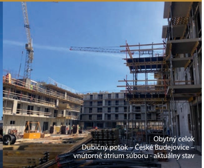
Hrubá stavba prvej etapy – 240 bytových jednotiek s polyfunkciou na 1NP.
