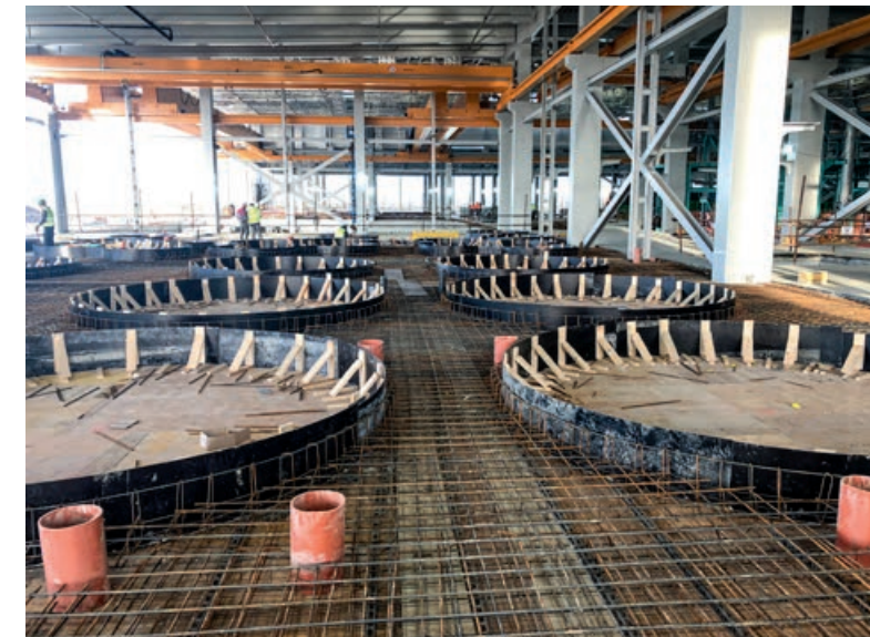
Výstuž stropnej dosky PLATING.
