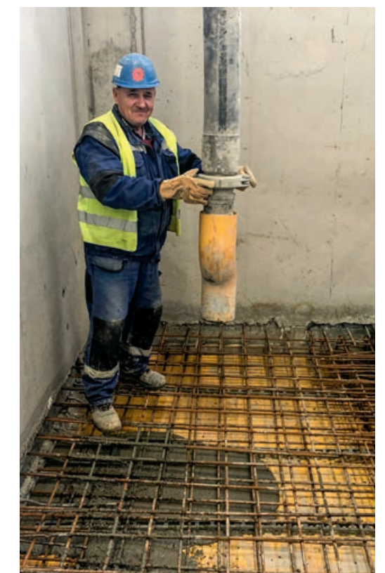
Dežko Szalai st. počas betonáže.
